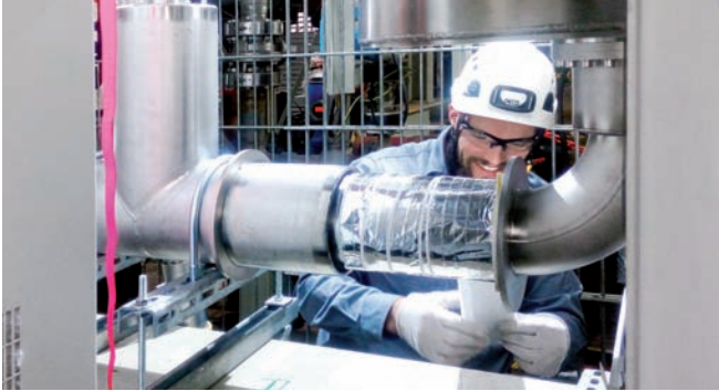
Supraleiterschienen mit Kryostat, Ø 200 mm
